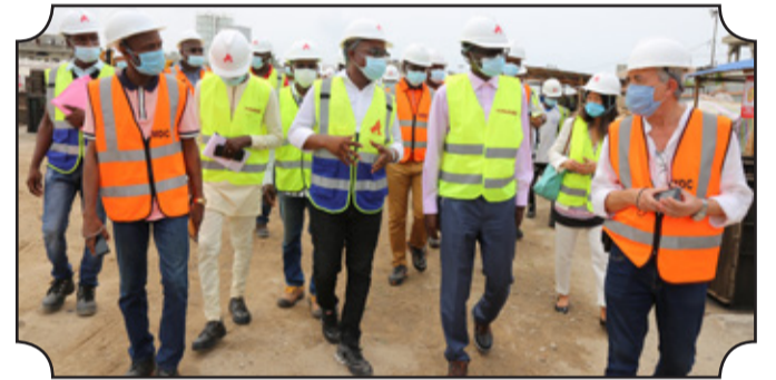
● La délégation de la BM sur un chantier du programme PAPC
